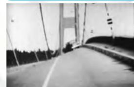
1940年在美国華盛頓州，當時被認為是第一流的吊橋「塔科馬海峽吊橋」在不到20m/秒的風速下崩塌。崩塌原因就是渦激振動。這是因結構體周邊或背後的渦流而產生的共振現象，只要結構體或其構成材料容易擺動的振動頻率能產生渦流，即使在低風速的狀況下也會產生振動。
